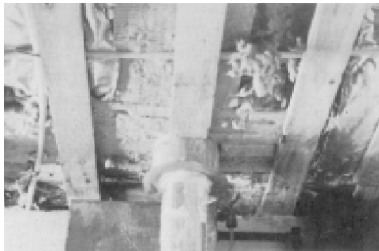
Ødelagte dampspærre
